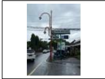
Gambar 6. Lampu Penerangan Jalan Sumber: Dokumentasi pribadi
