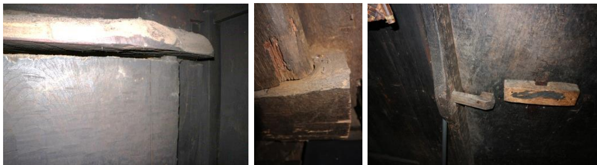
Gambar 3. Sambungan pintu Lamban Pesagi dengan menggunakan kayu (Sumber : Penulis, 2018)
