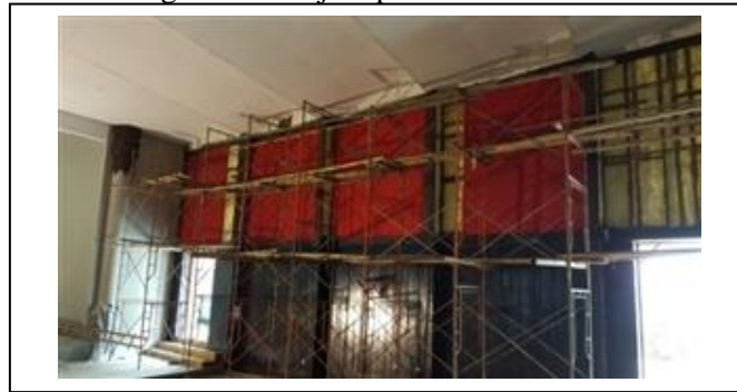
Gambar 22. Sistem peredam yang dipasang pada Auditorium RRI Surakarta Sumber: CV. Adiluhung Consultant
