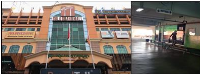
Gambar 1. Lokasi Mushola berada di Area Parkir Lantai 4
