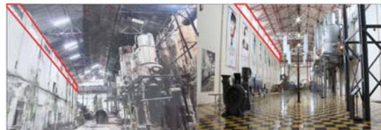
Gambar 15. Bukaan Pintu Jendela Bangunan Blok C Sumber: Analisis Penulis, 2021
