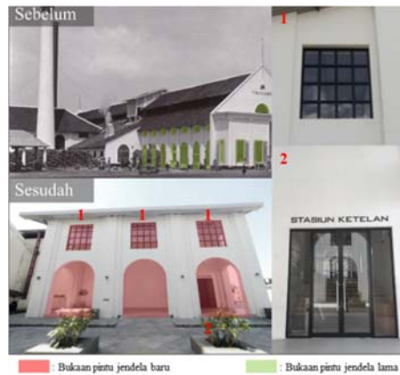
Gambar 14. Bukaan Pintu Jendela Sisi Selatan Bangunan Blok B Sumber: Analisis Penulis, 2021
