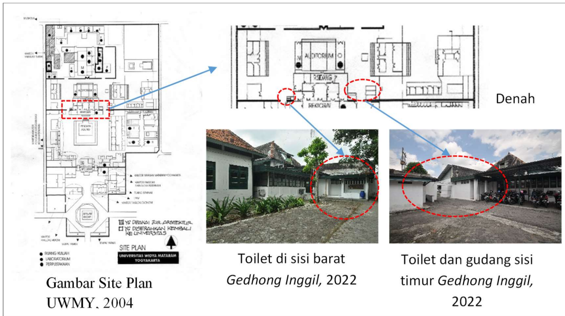
Gambar 7. Penambahan bangunan toilet di sisi barat dan timur Gedhong Inggil
