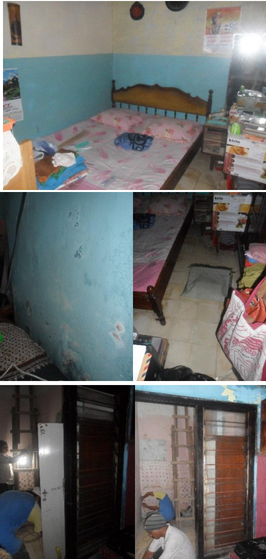
Ruang tidur (atas, tengah) dan gudang (bawah) Gambar 2. Kondisi ruang tidur dan gudang
